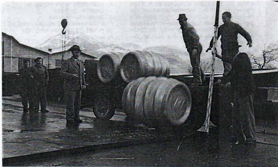
Après une chute 0,86m., pas une goutte de liquide perdue. Mesure de la déformation par MM. Garrone et Tamborini.
